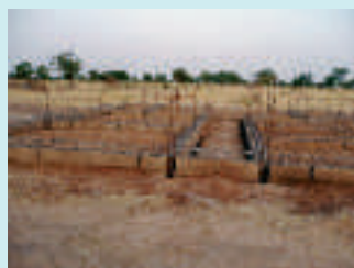
"Fondations et premiers travaux du Dispensaire de Zentenga faits avec l'apport des jeunes de Biville".
